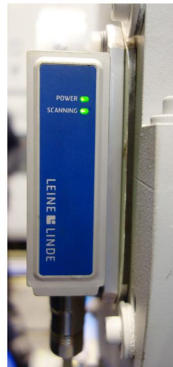
Der lagerlose Drehgeber wird direkt an einer Motorwelle mit großem Durchmesser angebracht.
